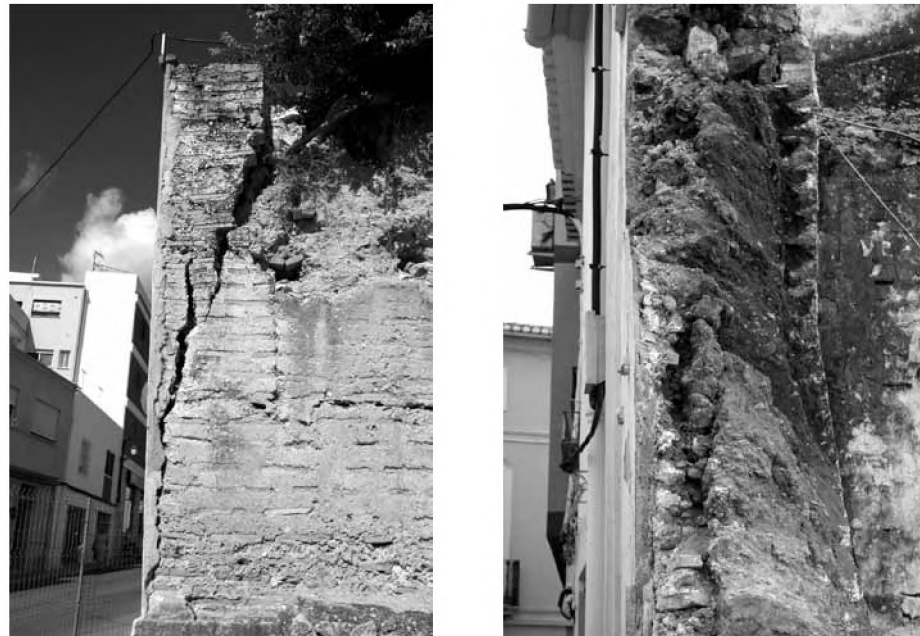
Fig. 17-18. Tapia valenciana (trapig del Verger) (Josep Ivars)
