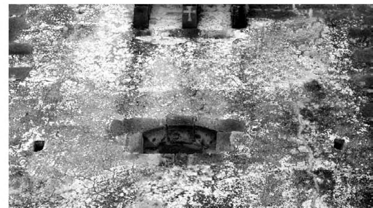
Fig. 23. Tronera esbocinada amb troneretes laterals (palau dels Medinaceli al Verger) (Josep Ivars)
