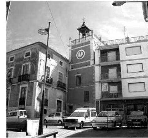
Fig. 20. Torre del rellotge abans de la recent intervenció (2011) (Josep Ivars)
