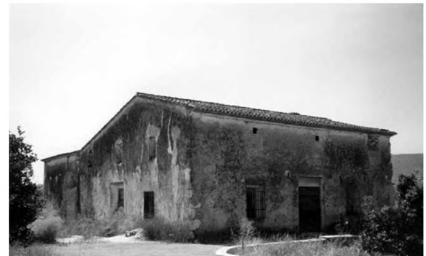
Casa de Benicarrac, desapareguda en favor d'una instal·lació equina.
