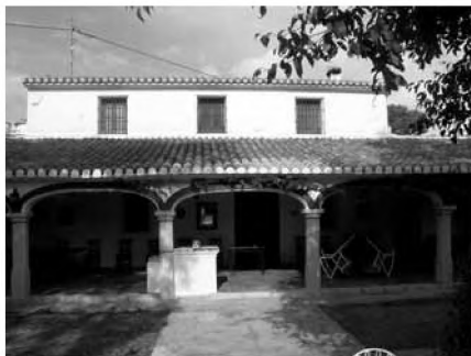
Alqueria riurau d'Iñareta (Pedregals)
