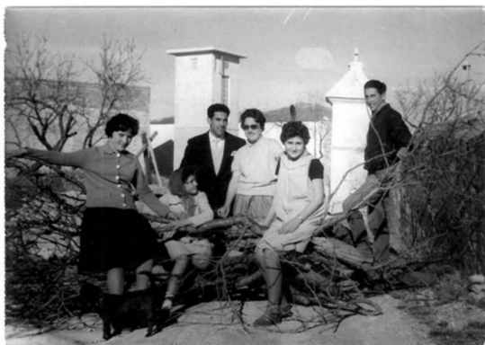
Figura 3. Posició original de la Capelleta I a l'encreuament del Carrer Constitució i Santa Anna. El transformador elèctric del Carrer Santa Anna n'és revelador.
