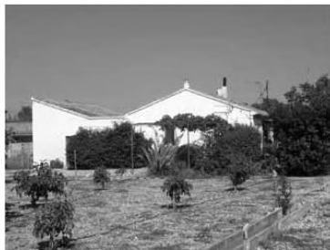
Caseta Bautista Pérez Doménech (Pedregals)
