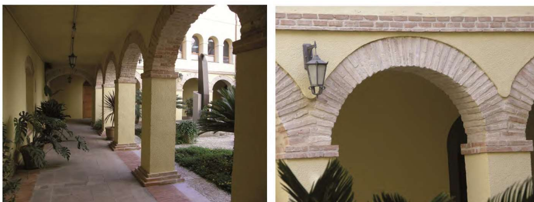
Vista de la galeria porticada i arcada original del Claustre
