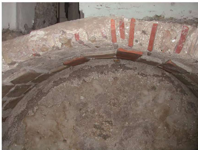
Detall de la volta de canó d'una de les fosses
